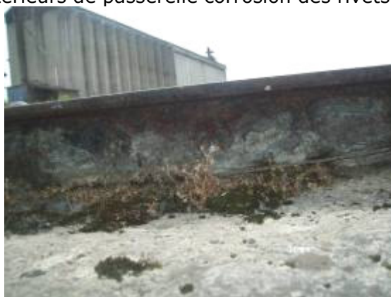
Intérieurs de passerelle corrosion des rivets
