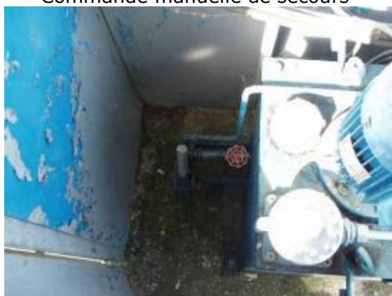
Commande manuelle de secours
