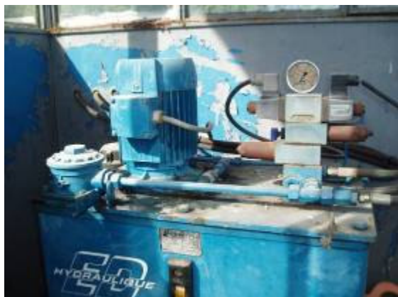
Commande manuelle de secours
