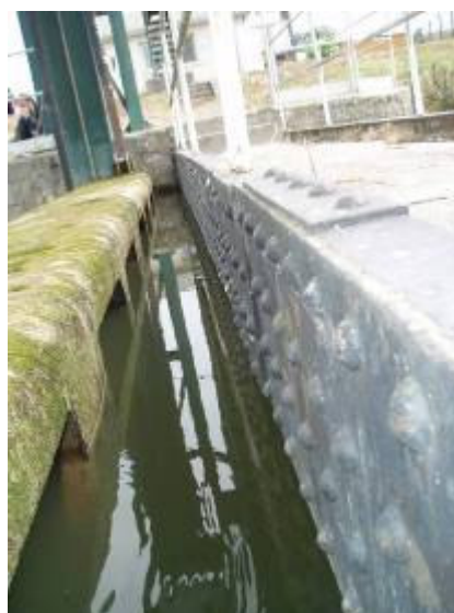
Intérieurs de passerelle corrosion des rivets
