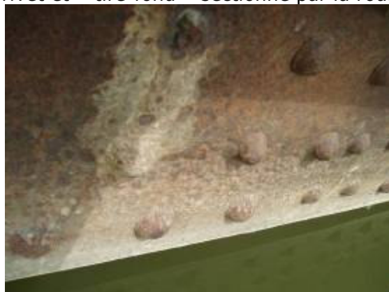
Absence de peinture, corrosion des têtes de rivet et « tire-fond » sectionné par la rouille
