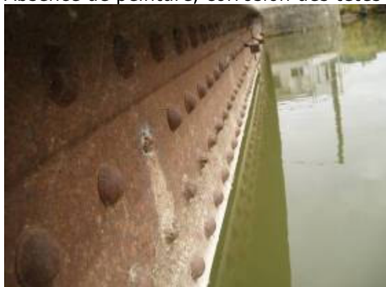
Absence de peinture, corrosion des têtes de rivet et « tire-fond » sectionné par la rouille
