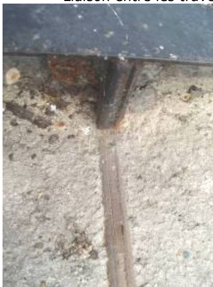
Liaison entre les traverses et les longerons
