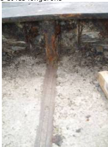
Liaison entre les traverses et les longerons
